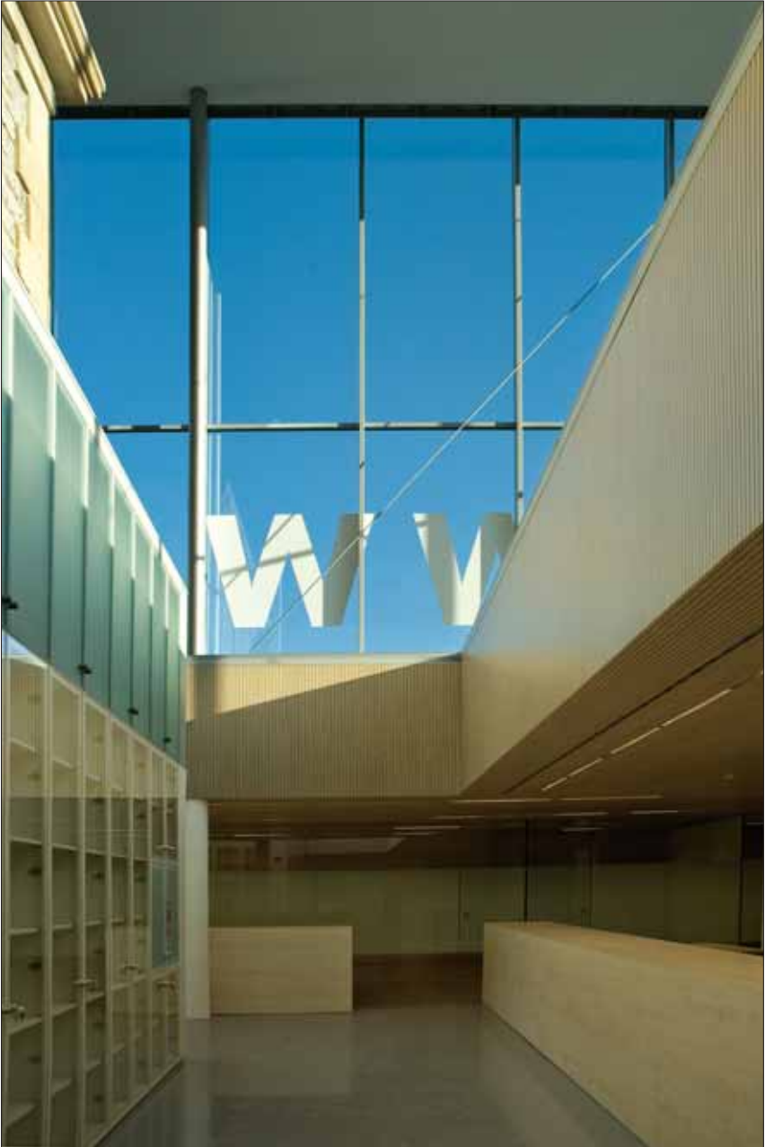
Vista interior grieta sala de consulta
